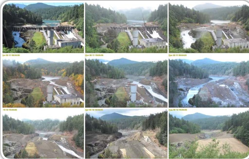
Figura 6 – Sequenza fotografica di alcune fasi della demolizione della prima diga che sbarrava il fiume Elwha (Washington, USA), avvenuta tra il 24 agosto 2011 e il 15 ottobre 2012.
