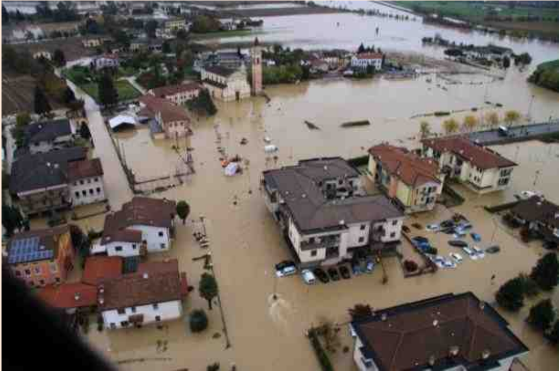
Straripamento del F. Muson, Castello di Godego (Treviso), 2010 (da: http://lrpress.it/2014/02/a-4-anni-dallalluvione-arriva-il-risarcimento-beffa-38-euro/ )
