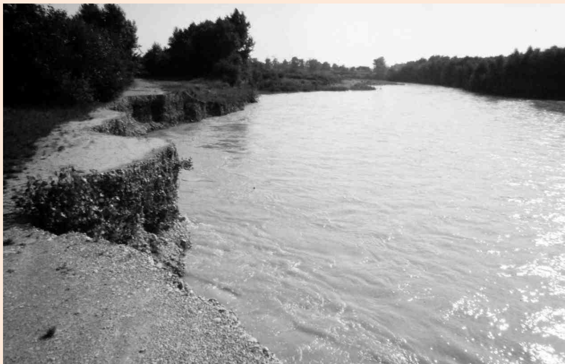
Erosione della riva nel basso F. Metauro (PU), che mobilizza i sedimenti nel loro transito verso il mare
