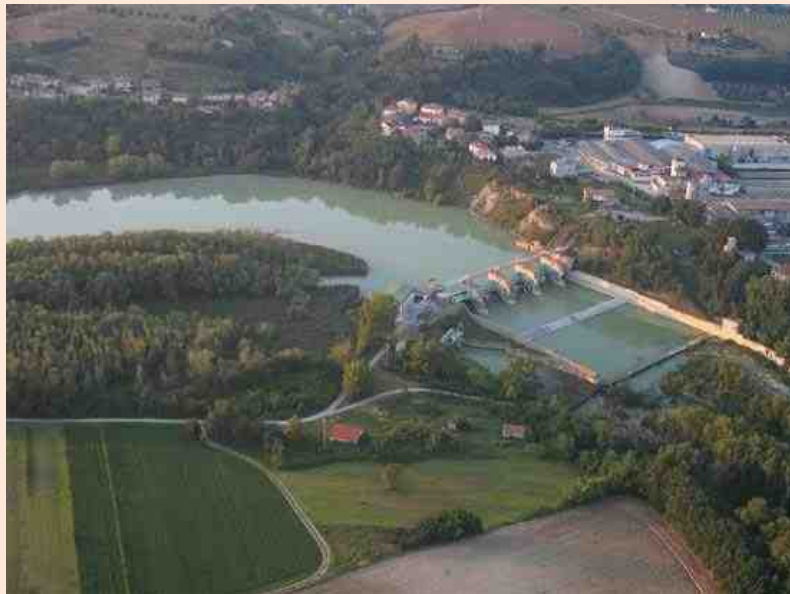
Diga lungo il F. Metauro (PU) (foto Roberto Pedini)
